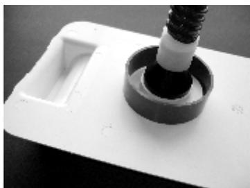
Stützhülse unter der Anschlussplatte einsetzen (siehe Foto)
