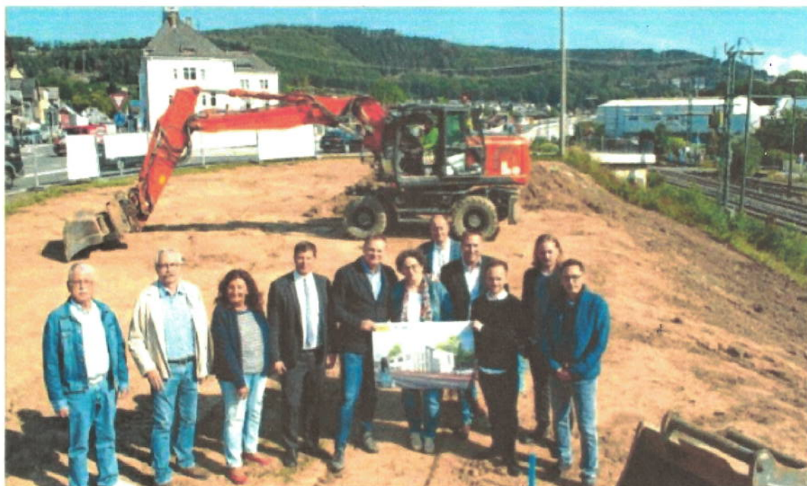
Die Vertreter der Familien Jung und Zahn als Gesellschafter der Fa. Zahntechnik Strunk freuten sich zusammen mit Architekten und Kommunalpolitikern über den Beginn der Bauarbeiten am Kreisel Foto: thor
